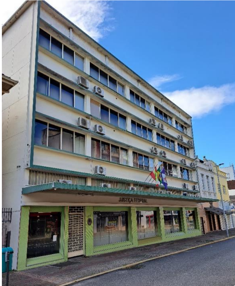
Figura 11: Sede da Justiça Federal, Rua do Príncipe, nº123.
