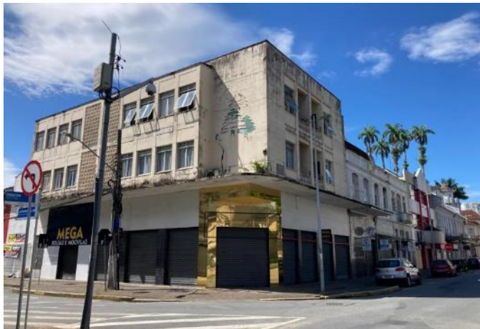
Figura 13: Edifício Beirute, Rua do Príncipe, nº 387.
