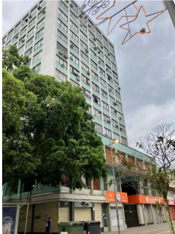
Figura 12: Edifício Manchester, Rua do Príncipe, nº330.
