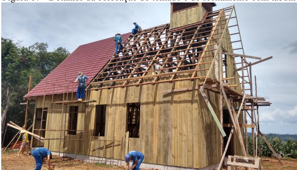
Figura 07 - Detalhes da colocação do telhado e do fechamento com tábuas.
