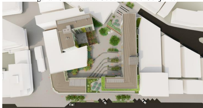
Figura 10 - Vista da Cobertura do Conjunto.
