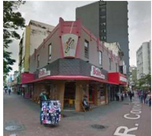
Imagem 05: Edifício Martinhago atualmente.
