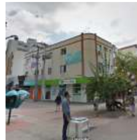
Imagem 19: Edifício Gaidizinsk atualmente.
