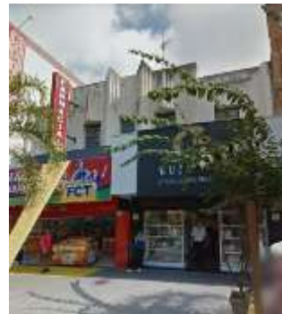
Imagem 15: Edifício Abilio Paulo Filho (atualmente).
