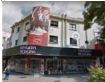
Imagem 11: Edifício Filhinho atualmente.
