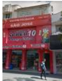
Imagem 13: Edifício Filhinho atualmente.
