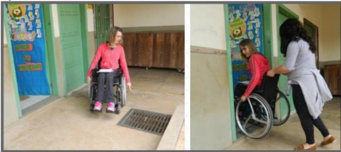
Figura 11 – Acesso à sala de aula: obstáculos
