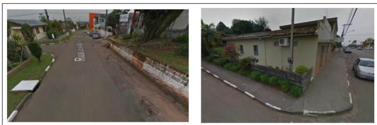
Figura 5 - Ruas do recorte em estudo: falta de padrão, acessibilidade ou calçada.
