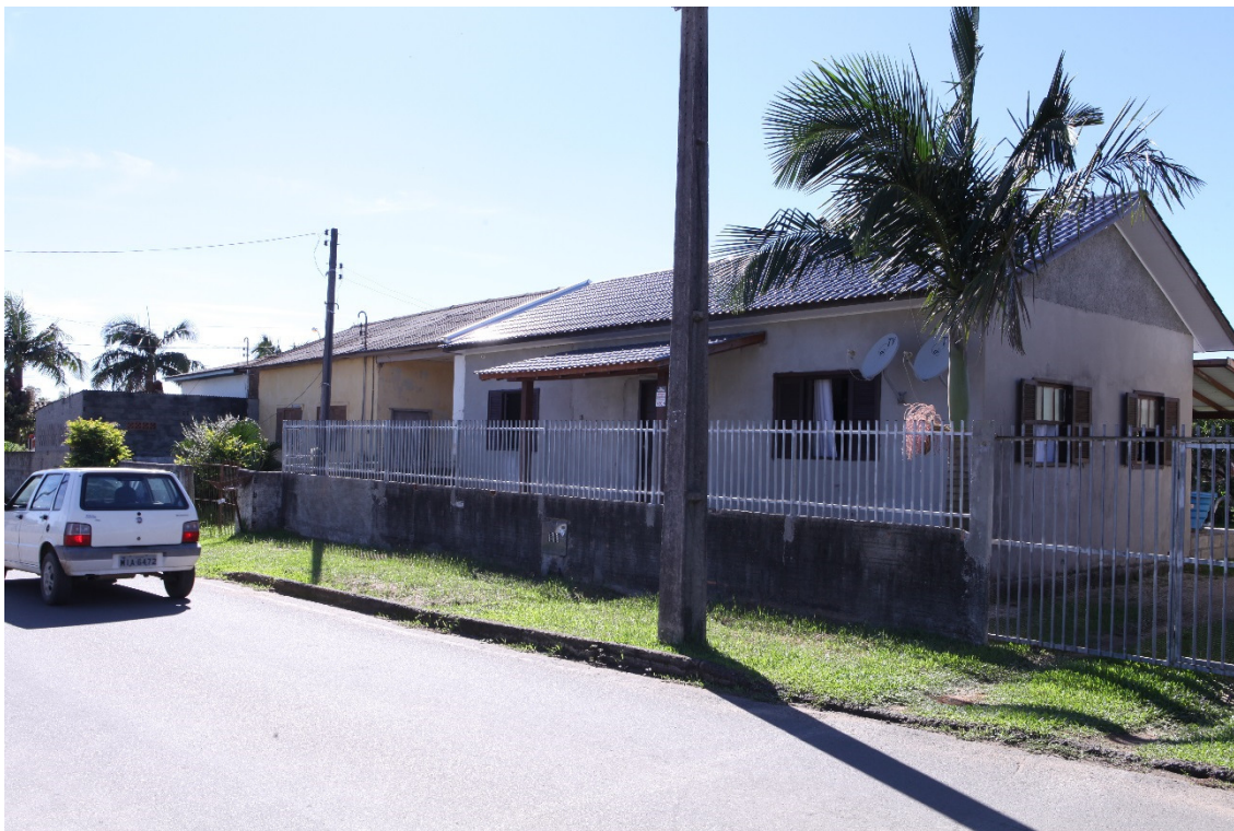
Casas geminadas. B. Mineração. Içara. Foto Gilmar Axé
