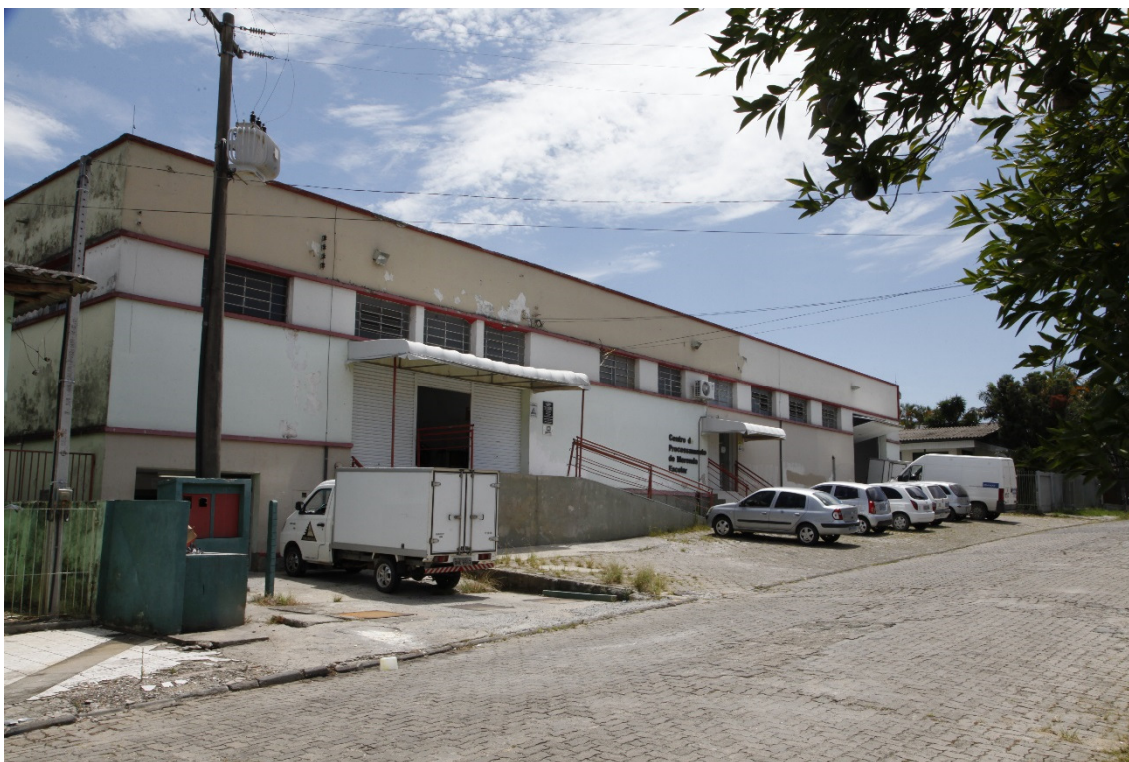
Central de Abastecimento da PM. Antigo Armazém da Próspera e Central de abastecimento do SESI. Bairro Próspera. Criciúma. Foto: Gilmar Axé
