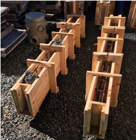
Figura 2a: Detalhe da fabricação das vigas.
