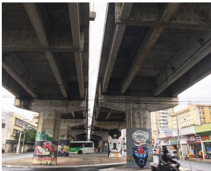
Figura 1 - Pilares do Viaduto da Ponte Leonel Brizola
