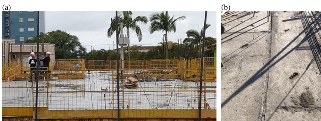
Figura 2 – Execução das lajes: (a)laje in loco e (b) laje pré-fabricada.
