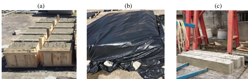
Figura 5: (a) Vigas recém concretadas; (b) Cura; (c) Vigas desformadas.
