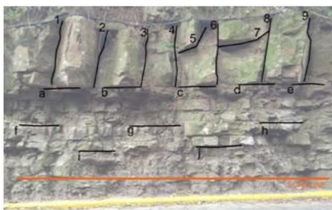
Figura 6. Descontinuidades que representam o maciço rochoso (Fonte: ZORZI; MÜLLER, 2019, p.12)
