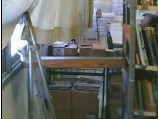
Figura 4. Estado físico do ambiente 3 em que está localizada a biblioteca.
