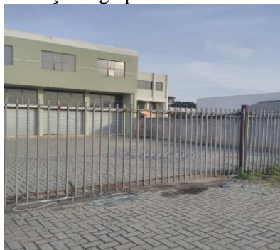
Figura 08 – Presença de galpões comerciais sem uso na área
