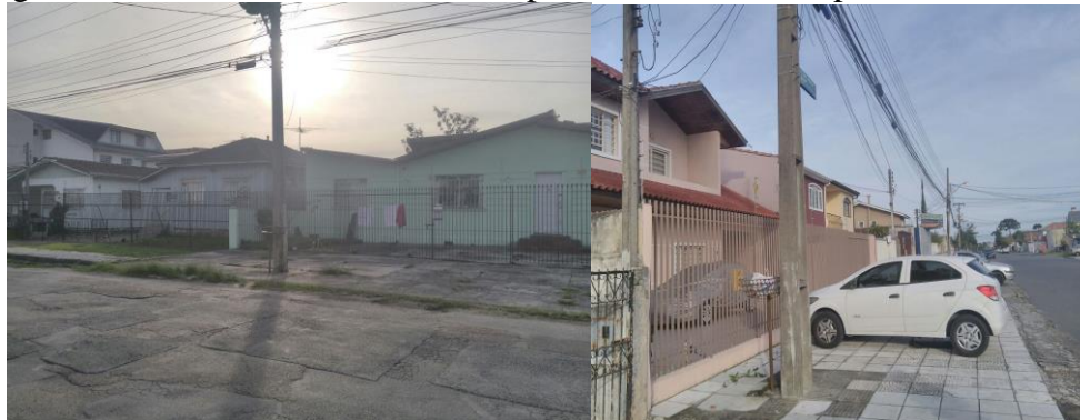
Figura 7 – Residências de um ou dois pavimentos na maior parte da área de estudo
